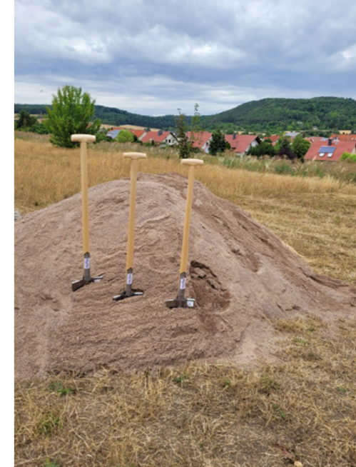
10 Jahre hat es bis zum Spatenstich zum Grundschulneubau in Bad Berka gedauert.
