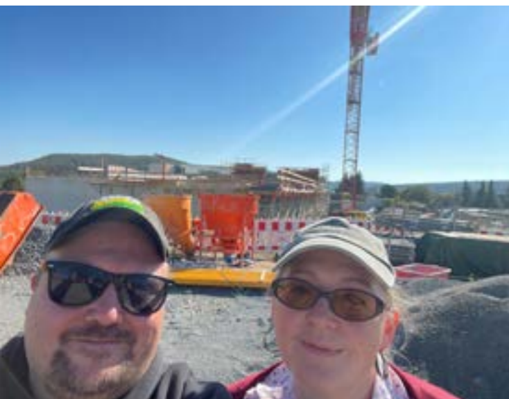
Constanze Kubitz und Kevin Reichenbach auf der Baustelle des Ersatzneubaus der Grundschule Bad Berka. Bild: Kevin Reichenbach
